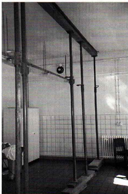
Katastrophaler Zustand der Grundschule Bad Elster: Notabstützungen innen (links) und Putzschäden außen (rechts).
